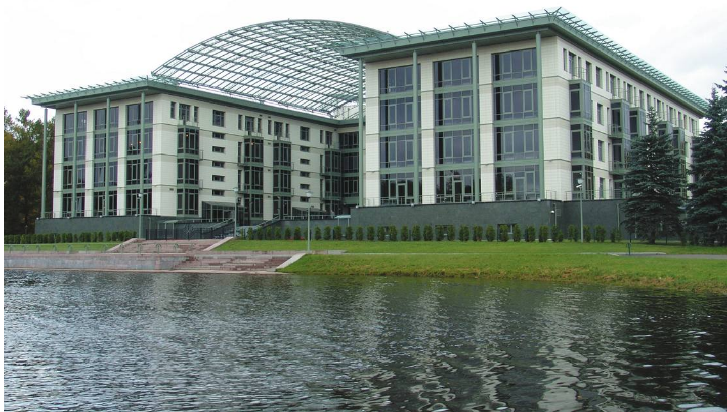
ЖК «Пятый Элемент», г. Санкт-Петербург, 7 000 м 2
